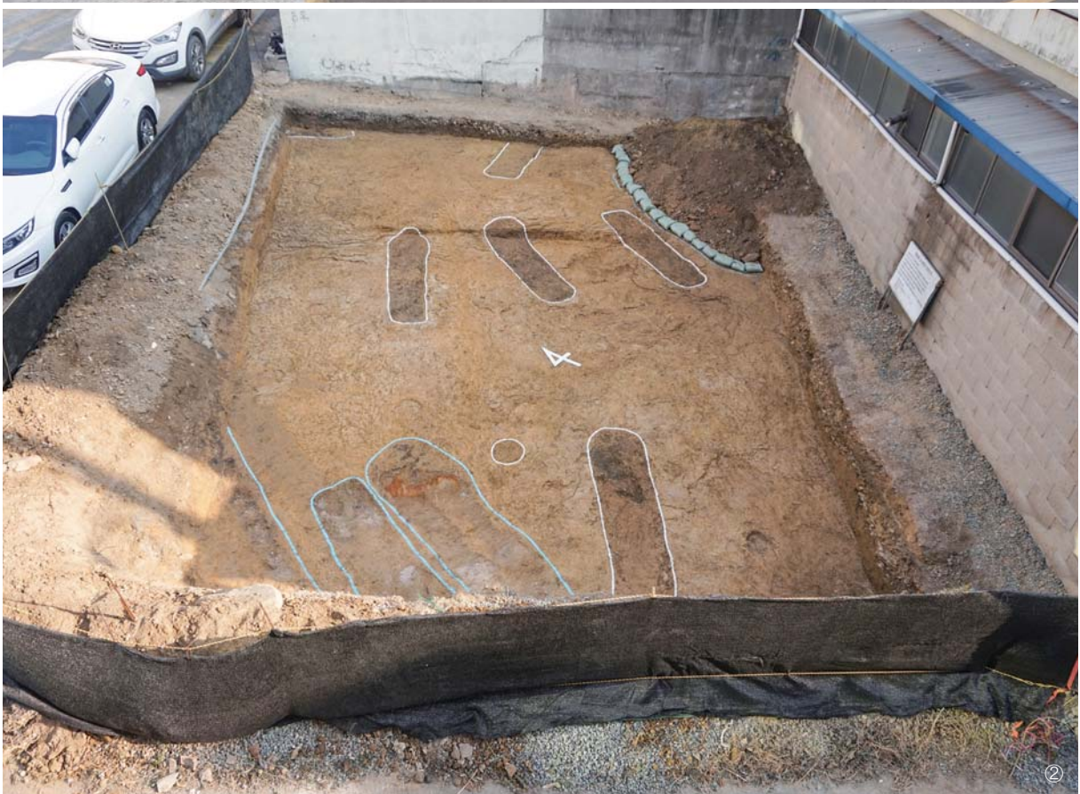
도판 1. 조사대상지 전경(①조사전(N-S), ②조사중(SW-NE))
