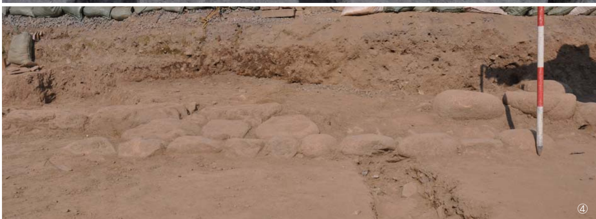
도판 24. 기단석렬 1호(①③조사중(SE→NW), ②④입면)
