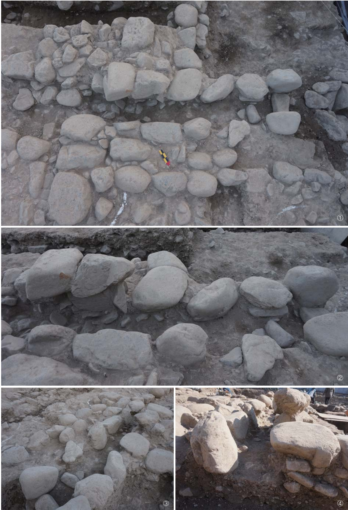
도판 23. 배수로 1호(①조사중(N-E→S-W), ②③입면, ④단면 토층)
